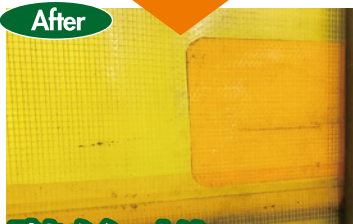
破れたシートはパッチあて補修でOK
