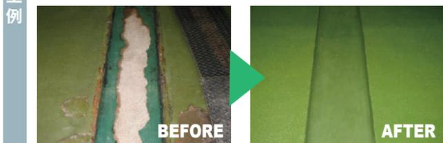
油分を含んだ熱湯を頻繁に流す側溝を含めて、水系硬質ウレタン床材を施工。清掃しやすくするために、入隅をR加工しました。
