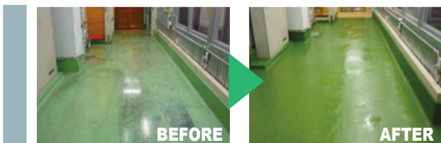
食品製造現場で油分を多く含む原材料を使用し、重量物の運搬が多いことを考慮して水系硬質ウレタン6mm厚を施工。
