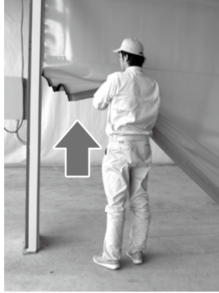
② 真上方向に持ち上げることでシートはチューブガイドから外れます。
