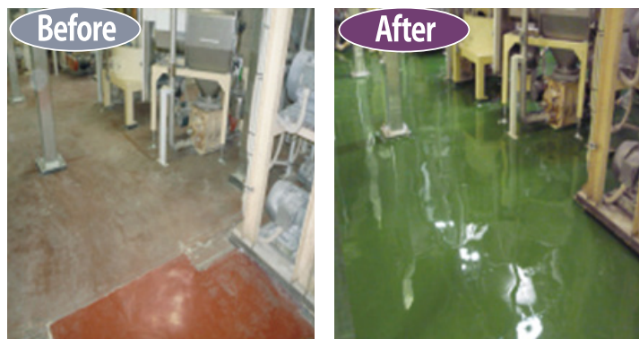
■高硬度ウレタン塗り床施工例
