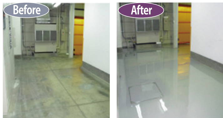
■高硬度ウレタン塗り床施工例
