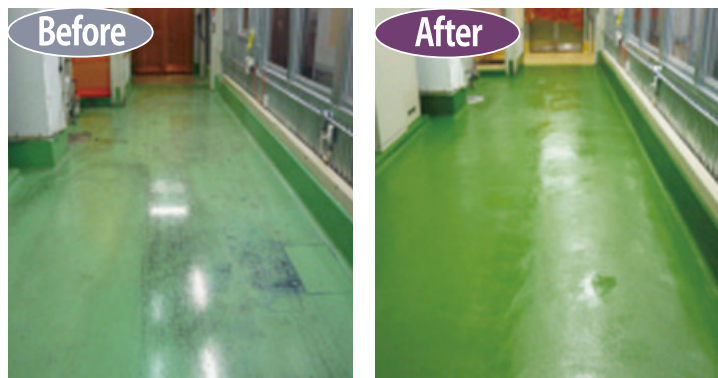
■水系硬質ウレタン塗り床施工例
